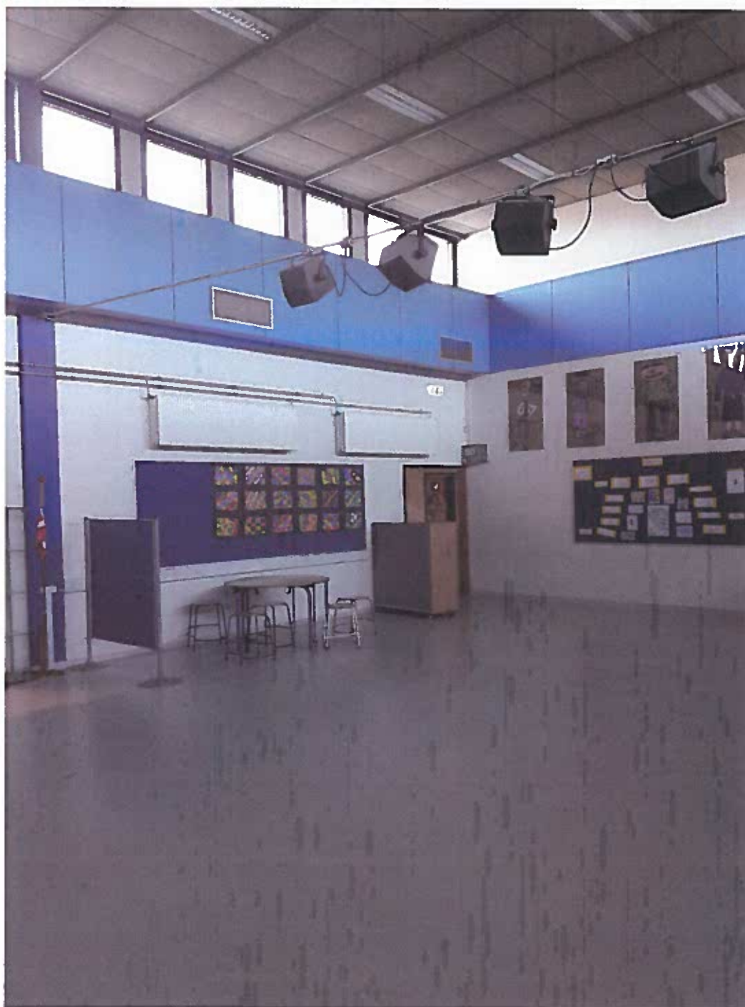
Der hænger 6 lamper i rummet i omtrent 3 meters højde. Bemærk at de blå afdækningskasser under vinduerne har vandrette overflader.
